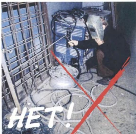
Место проведения огнеопасных работ следует обеспечить первичными средствами пожаротушения и очистить от горючих материалов.
