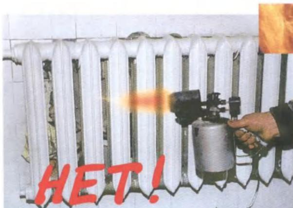
Запрещается отогревать замерзшие приборы отопления и водопроводные трубы открытым огнем.
